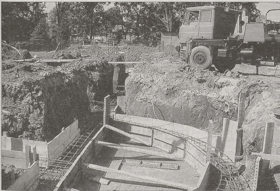
Budowa fundamentów pod nowobrzeńską salę gimnastyczną
