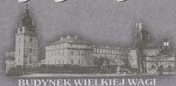
BUDYNEK WIELKIEJ WAGI
