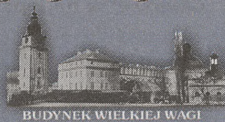
BUDYNEK WIELKIEJ WAGI
