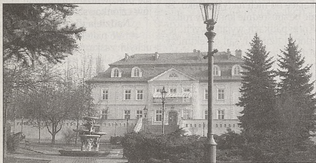
Późnobarokowy pałac Konopków z łamanym, tak zwanym polskim dachem oraz dobudowanymi lukarnami na poddaszu
