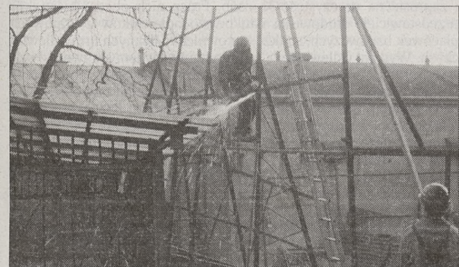
Rozpoczęły się wyburzenia
