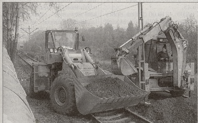
Ul. Kocmyrzowska: remont torowiska od ul. Darwina do cmentarza w Grębałowie (wstrzymany ruch tramwajów) - do 29 listopada.
