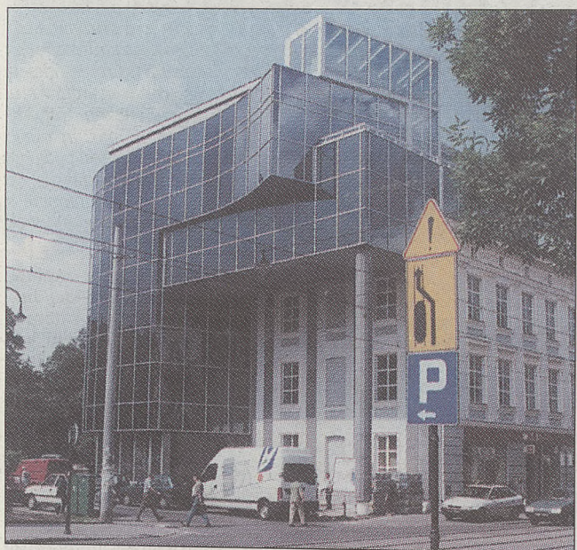
Budynek biurowy przy ul. Zwirynieckiej w Krakowie
