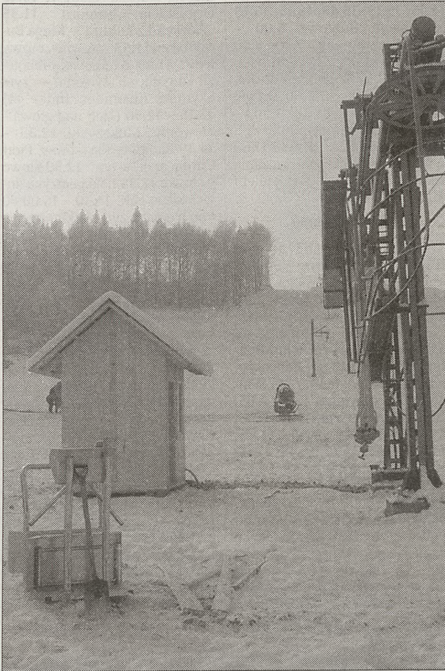
Sprzęt jest przygotowany, ale prace jeszcze trwają
