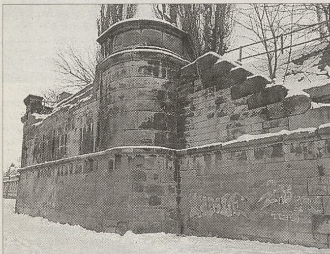
Przyciółek mostu Podgórskiego będzie bazą platformy widokowej Fot. Anna Kaczmarz
