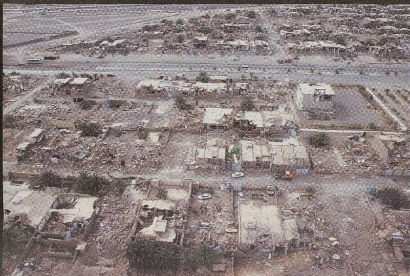
Tylko gruzy pozostały z około 70 proc. budynków mieszkalnych w mieście Bam
