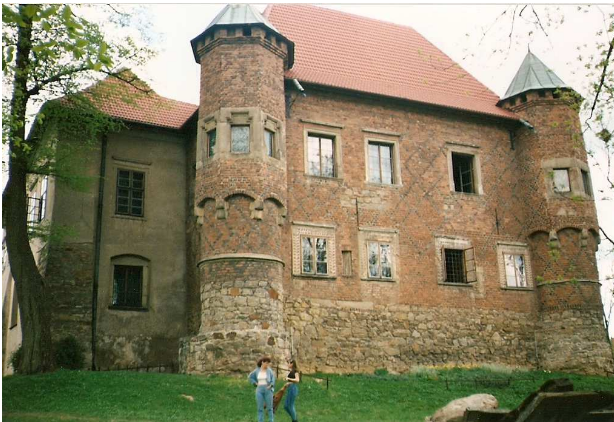
Fot. nr 74. Widok na tylną, zachodnią elewację, z okrągłymi, późnogotyckimi basztami i kamiennym fragmentem ściany. (1996).
