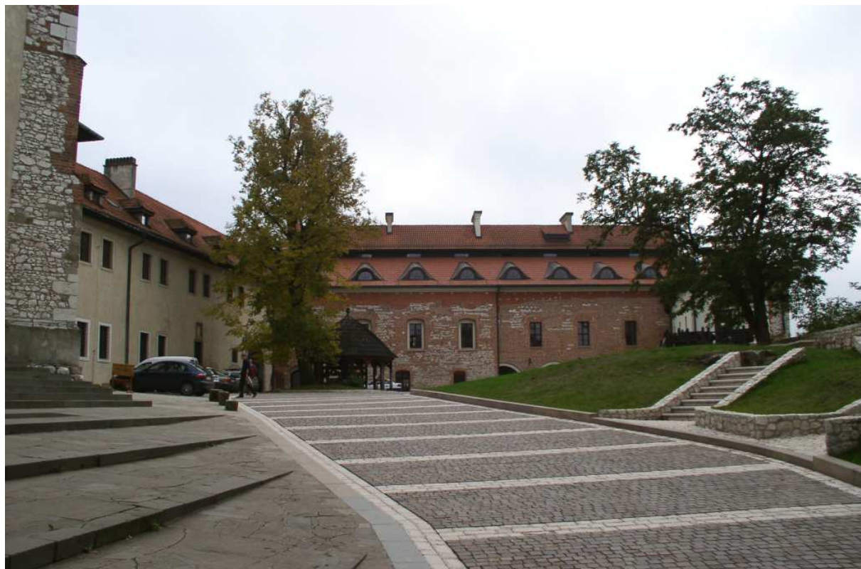
Fot. nr 21a (21a-21b). Stan po rekonstrukcji. (10.10.2008)
