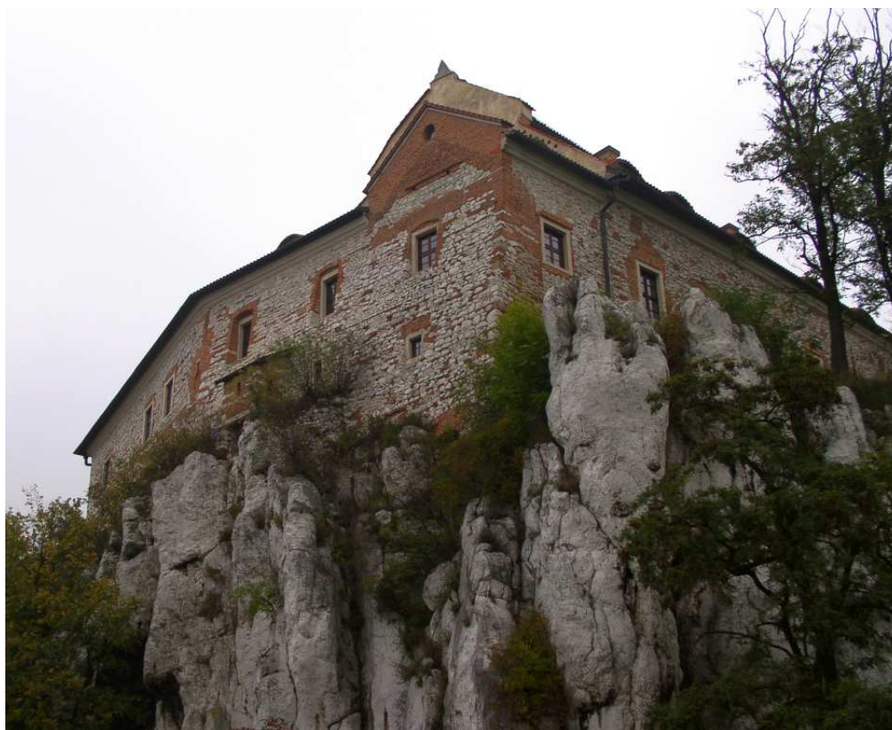
Fot. nr 29. Stan po rekonstrukcji. (10.10.2008).
