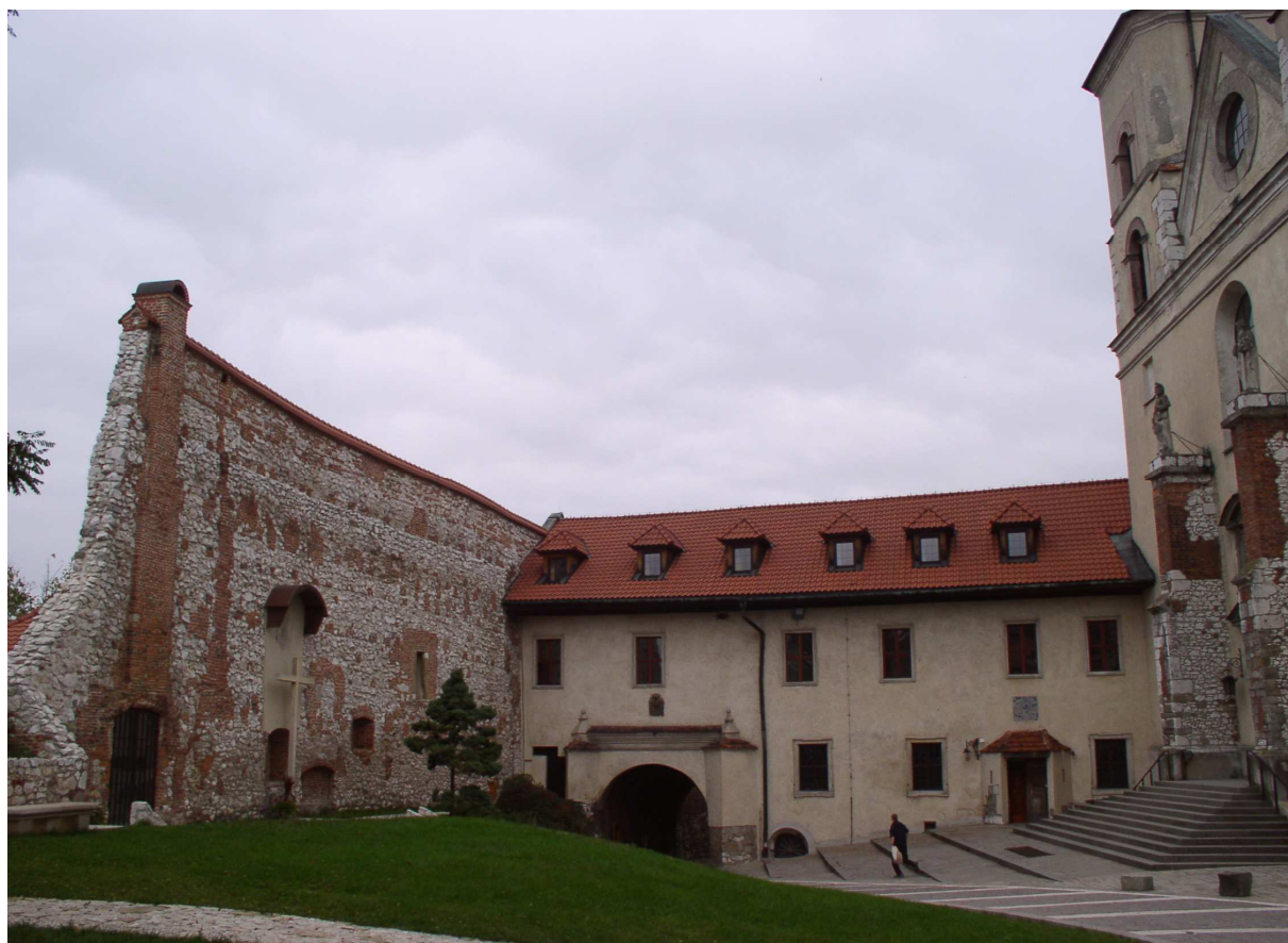
Fot. nr 17. Widok na narożnik północno-zachodni – stan z 10.10.2008.
