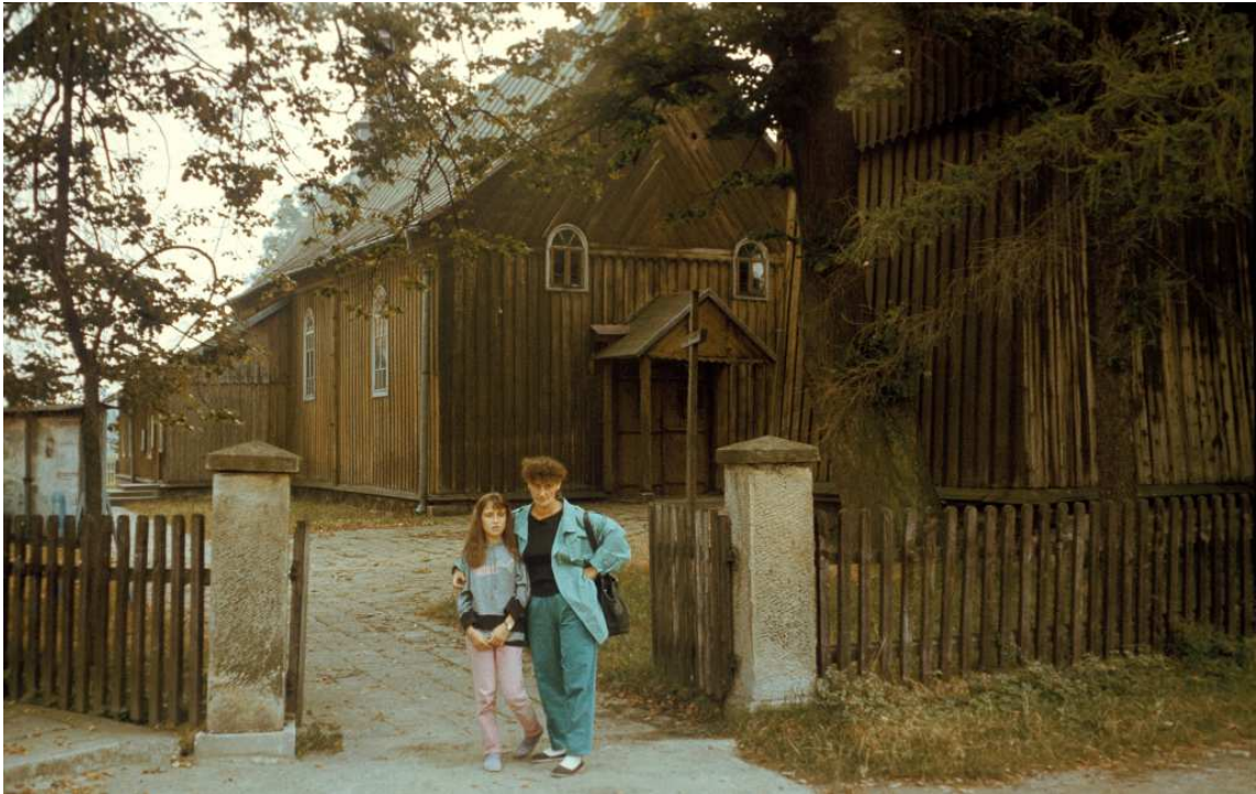
Fot. nr 48 (48-48c). Drewniany kościół p.w. św. Bartłomieja z przełom XVI i XVII wieku. Stan sprzed remontu, tu z roku 1992.
