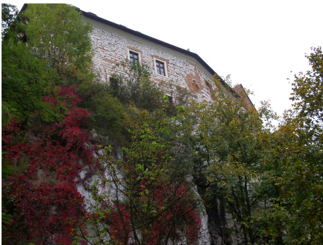
Fot. nr 27. Stan po rekonstrukcji. (10.10.2008)
