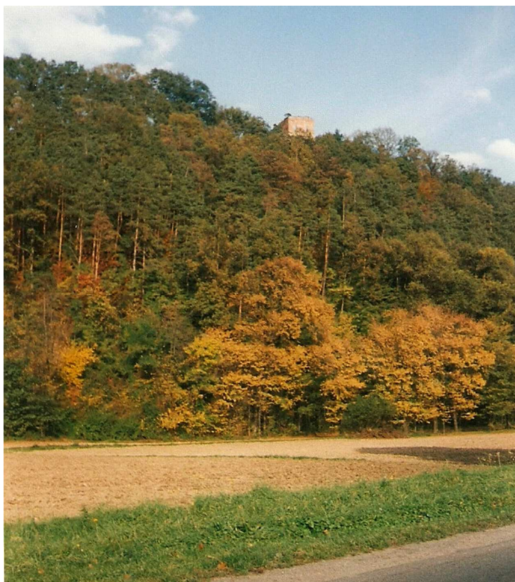
Fot. nr 81. Ruina wieży zamku w Melsztynie, którego początki sięgają XIV wieku. (1994).
