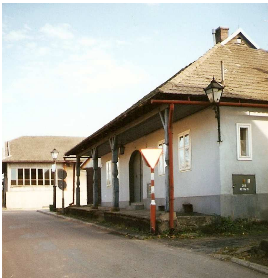
Fot. nr 102. Przy wylocie z Rynku przy ulicy Grunwaldzkiej 1.
