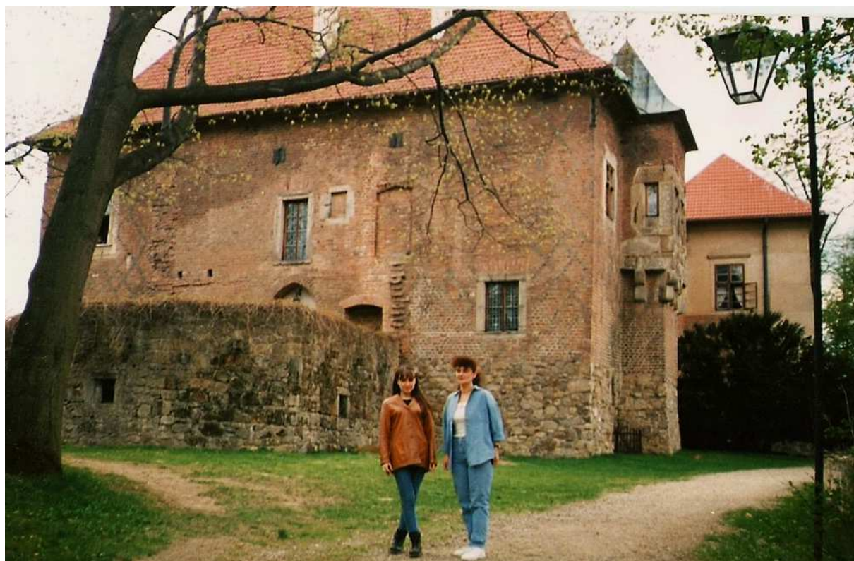
Fot. nr 73. Wejście od strony wschodniej i ściana północna. (1996).
