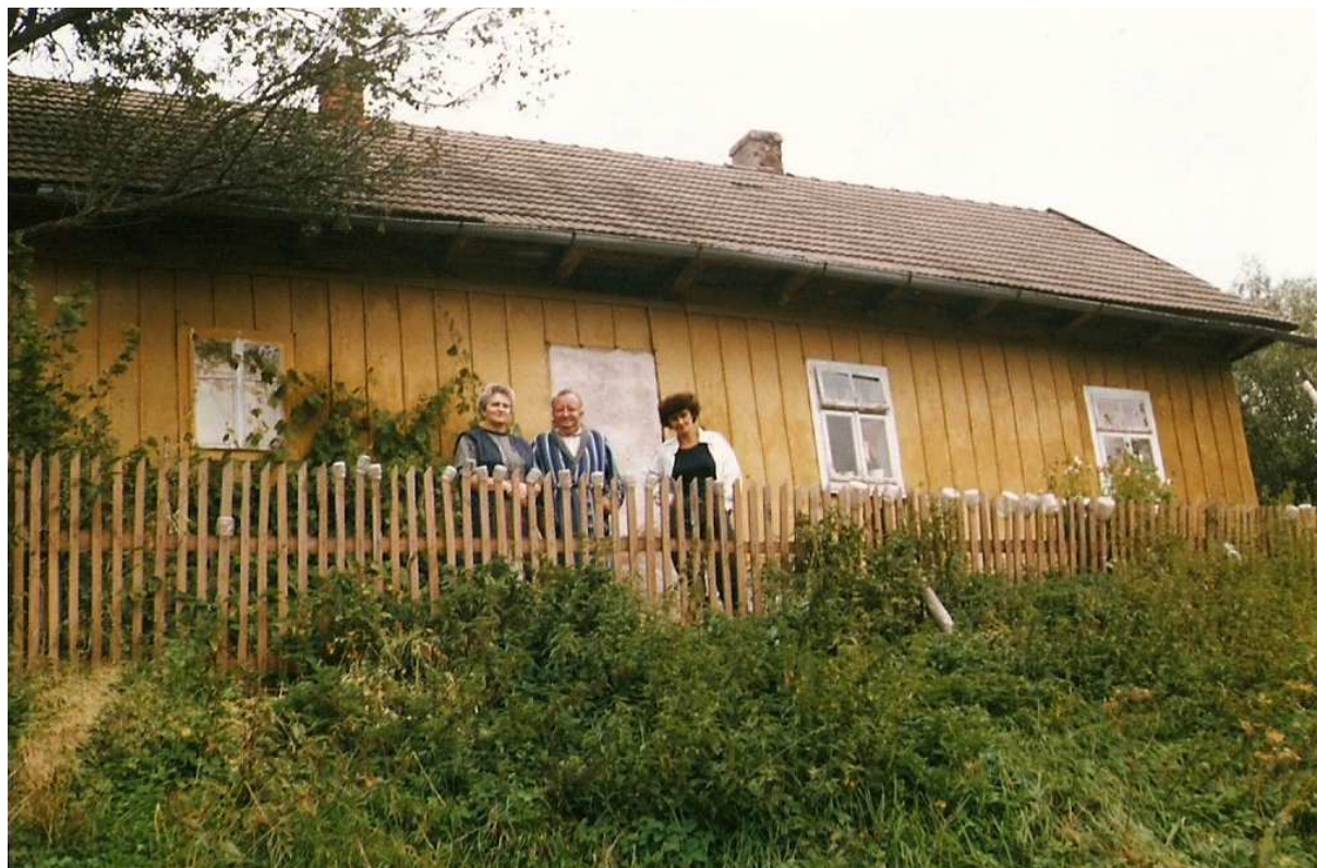
Fot. nr 92 (92-93). Borowa koło Zakliczyna. Oszalowana, tradycyjna chałupa z oknami trójskrzydłowymi. (1998).
