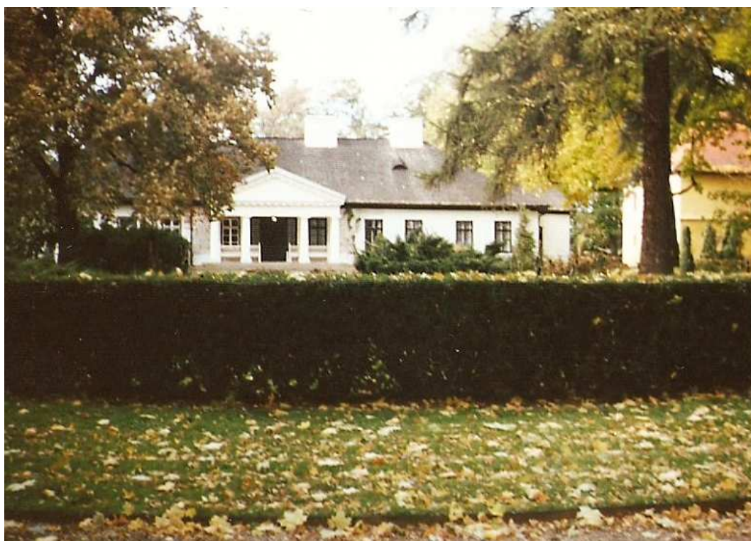
Fot. nr 95. Fasada klasycystycznego dworku z rodowodem z początku XIX. wieku. (1994).
