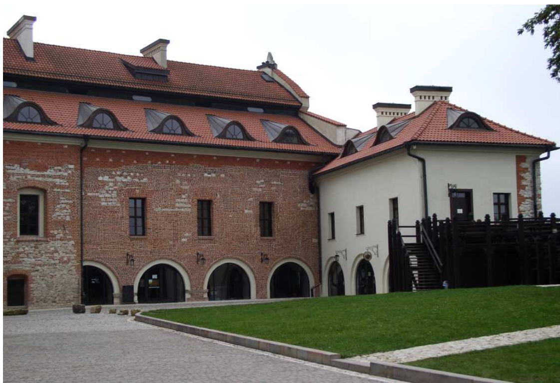
Fot. nr 22. Widok na zrekonstruowaną dobudówkę w narożniku południowo-zachodnim. (10.10.2008)
