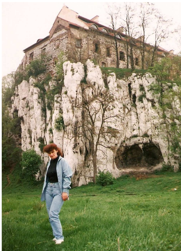
Fot. nr 28 (28-29). Narożnik południowo – zachodni. Widoki od strony Wisły. Wygląd w stanie ruiny w roku 1996.
