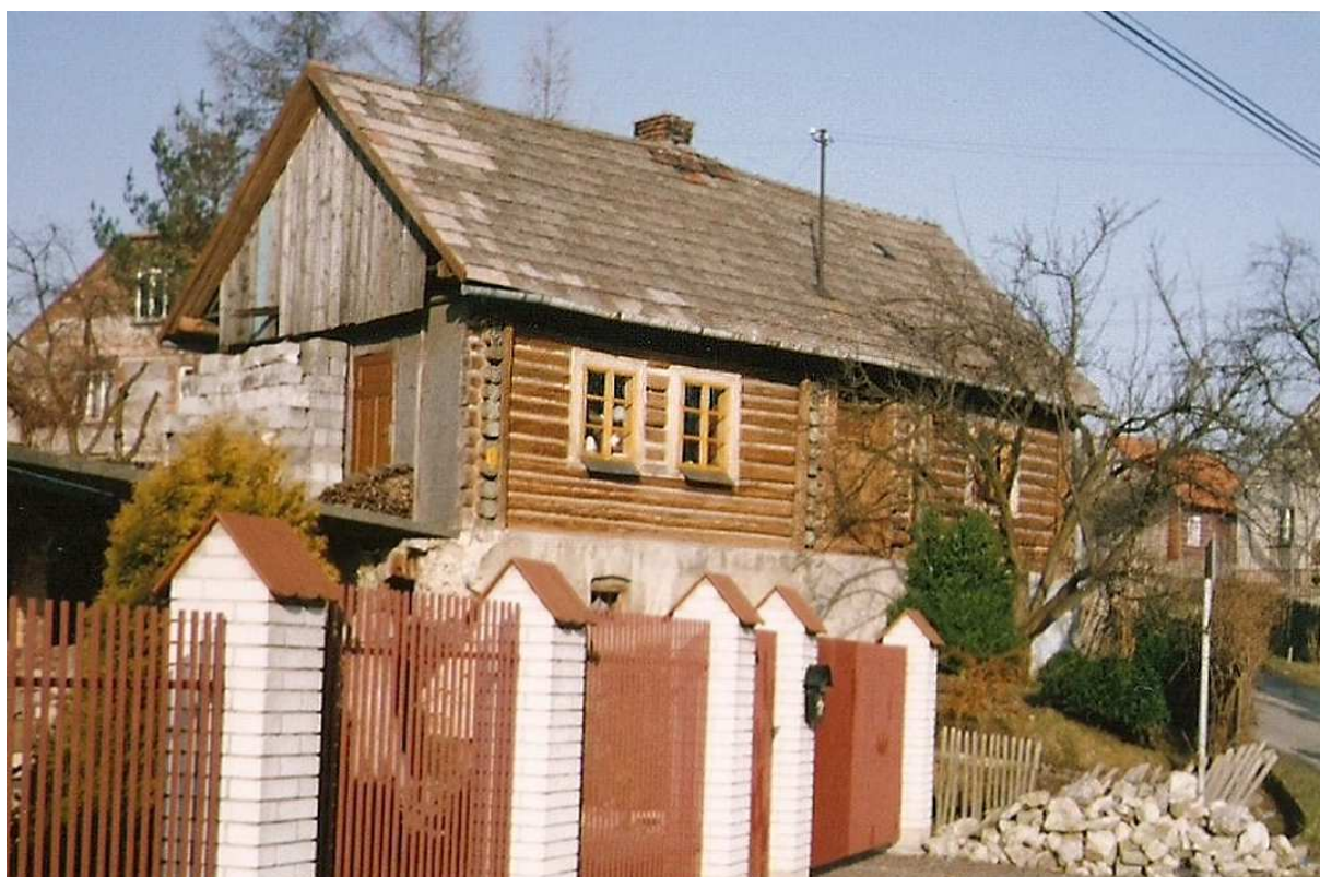
Fot. nr 33 (33-35). Stare chałupy w Kobylanach. Pierwszy z antyków, wybudowanych zapewne na początku XX wieku.. (2000)
