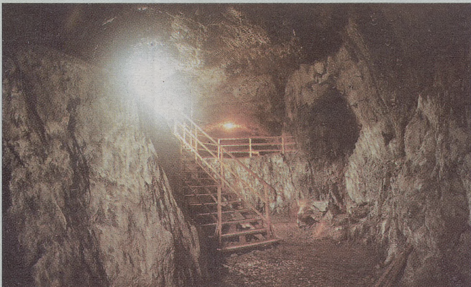
Sztolnie i hale kompleksu „Osówka” budowano dwupoziomowo
