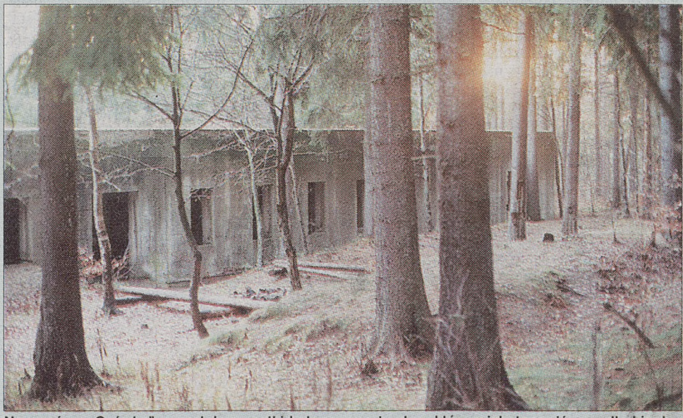
Na wzgórzu „Osówka” pozostały szczątki betonowego bunkra, który miał stanowić – wedle hipotez – jedno z centrów dowodzenia podziemną fabryką „Riese” (Olbrzym)
