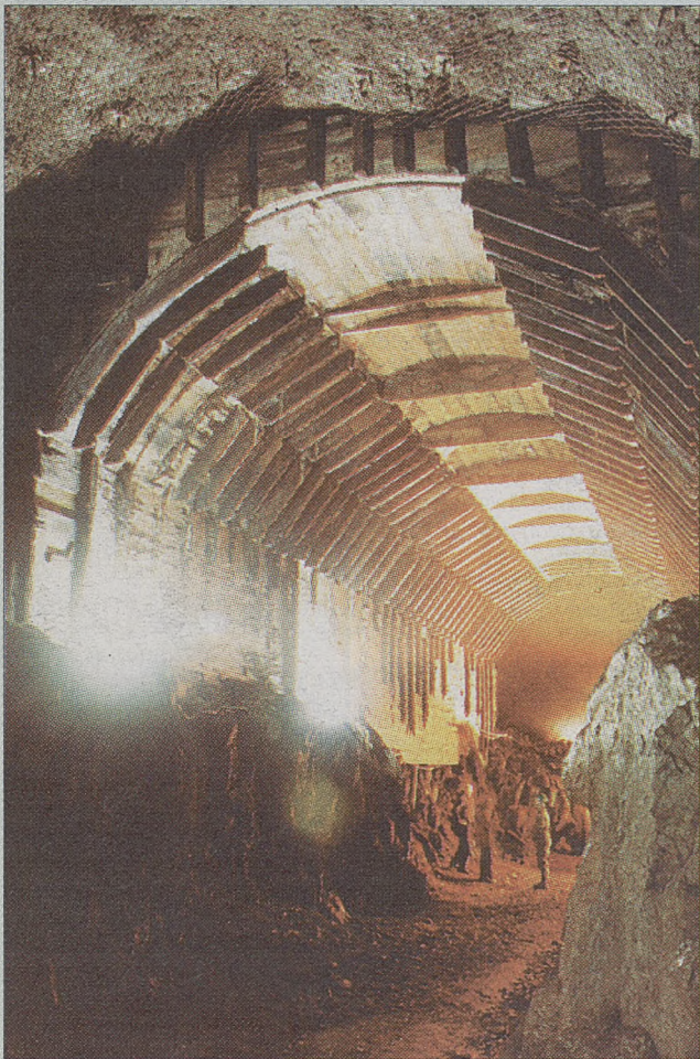
Kompleks „Osówka” – częściowo obudowana hala o wysokości 8 metrów i długości 50 metrów
