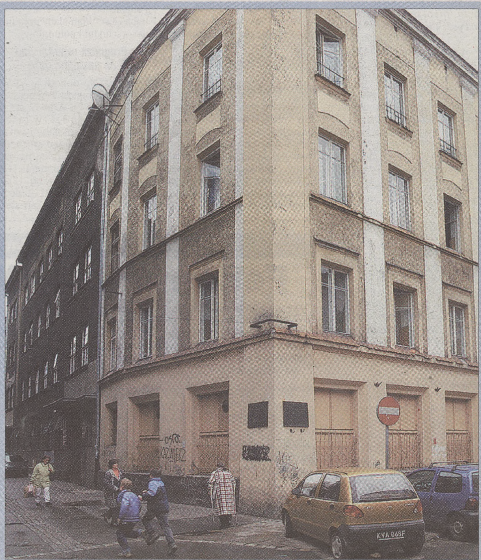
Budynki przy ul. Podbrzezie 10 i Brzozowej 5 przed wojną stanowiły jedną całość
