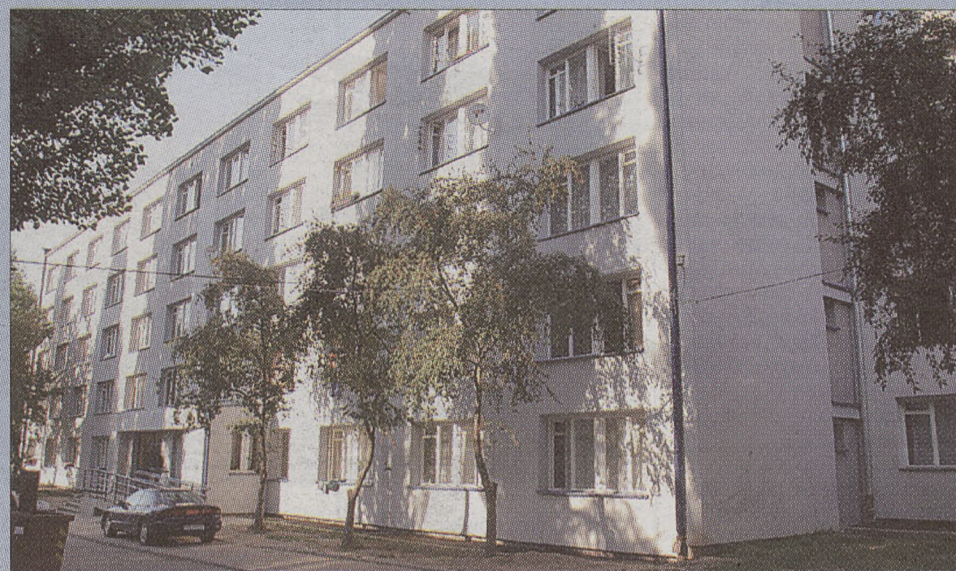
Blok komunalny stał się postrachem osiedla Złotej Jesieni za sprawą kilku chuligańskich rodzin, które zastraszały sąsiadów, niszczyły budynek, urządzały pijackie imprezy
