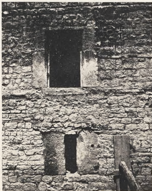
Okno romańskie (dolne) odkopane i okno gotyckie (górne) w ścianie południowej wieży Srebrnych Dzwonów. Fot. H. Kramkowski.
