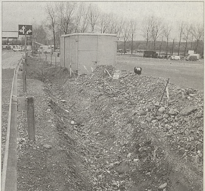
Postawiono barierki i usunięto rury z rowu Fot. Andrzej Wiśniewski
