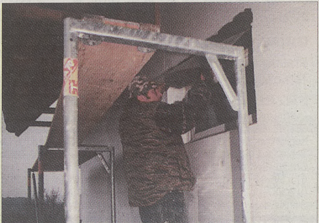
Montaż systemu dociepleniowego
