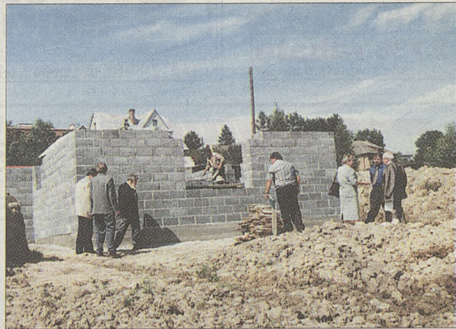
Ściany wykonane zostały z betonu komórkowego
