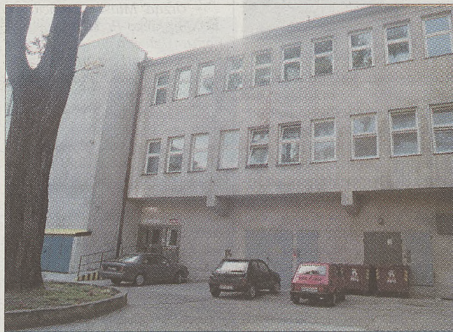
O budynek szpitala przy ul. Siemiradzkiego upominają się spadkobiercy dawnego współwłaściciela
