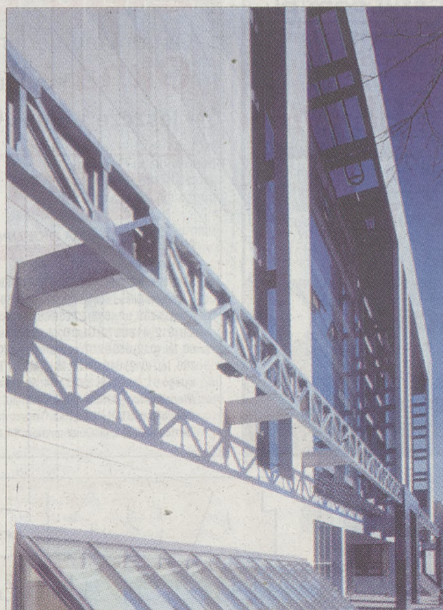
Nagroda specjalna: budynek „K” Sądu Okręgowego w Krakowie
