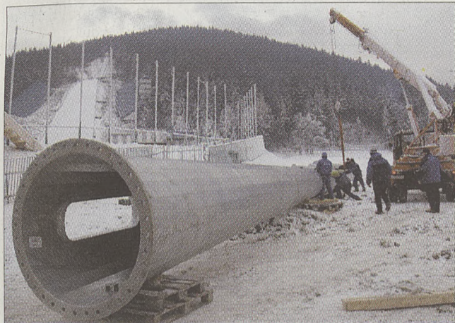
Trwa montaż oświetlenia na Wielkiej Krokwi. Maszty oświetleniowe wkrótce zostaną zamontowane przy użyciu śmigłowca. Fot. PAP
