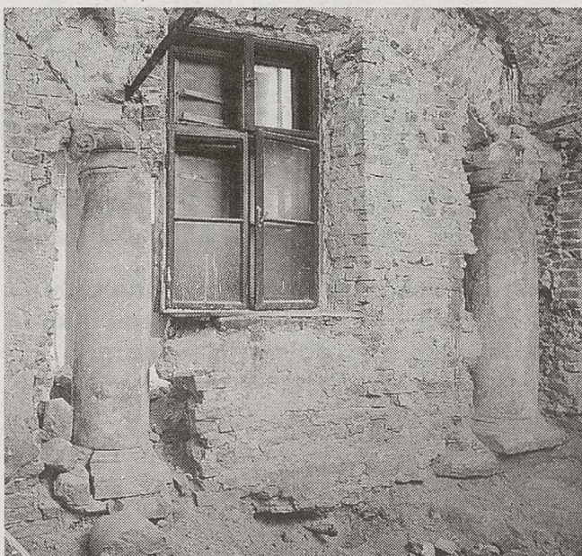
Od 1999 roku pałac jest remontowany
