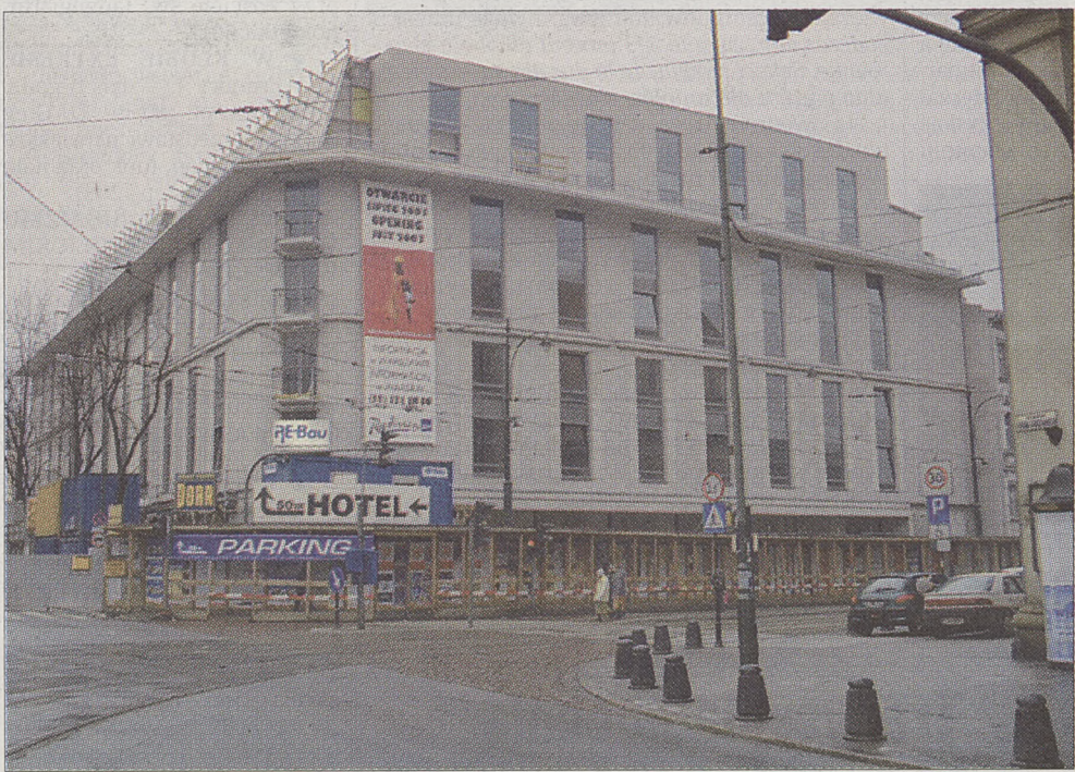
Nowy hotel Radisson przy filharmonii zostanie otwarty prawdopodobnie w lipcu br.
