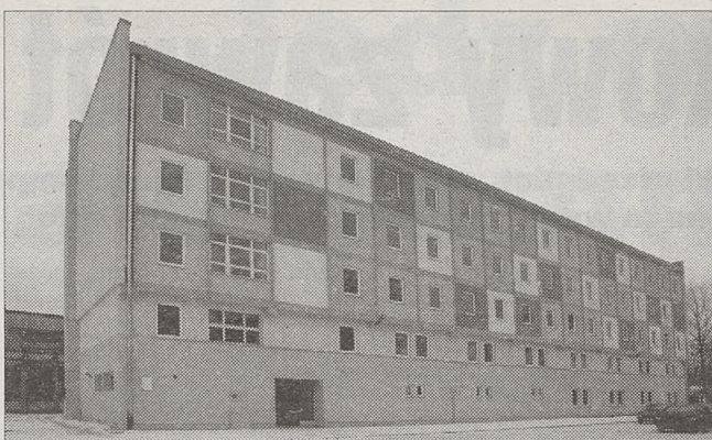
Odremontowany przez krakowski Montin budynek w Nowej Hucie
