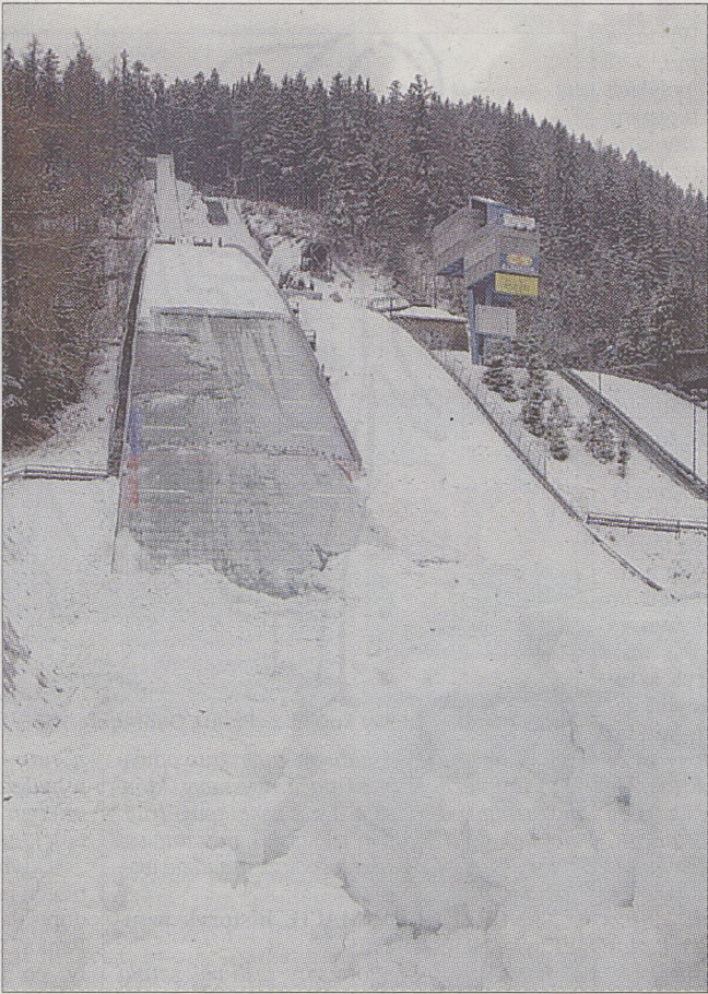
Uszkodzony igelit na Średniej Krokwi
