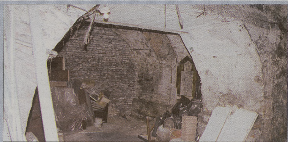
Jedna z piwnic znajdująca się pod pałacem Pod Krzysztoforami
