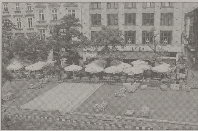
Kończą się prace przy nowej nawierzchni jezdni wokół Rynku - na odcinku od ul. Szewskiej do św. Jana
