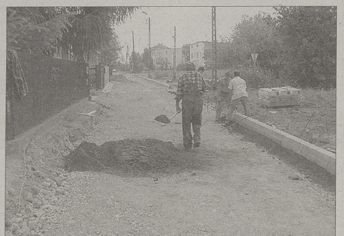
Wykonawca zamierza skończyć budowę drogi dwa tygodnie przed ustalonym terminem
