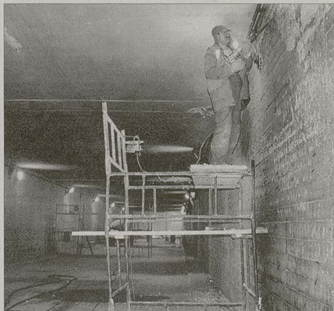
Remont tunelu pod rondem Grunwaldzkim ma potrwać do 28 lutego 2002 roku
