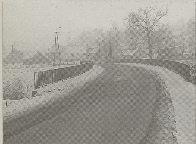
Na 120 tys. euro wyceniono przebudowę w Radziszowie mostu na Skawince
