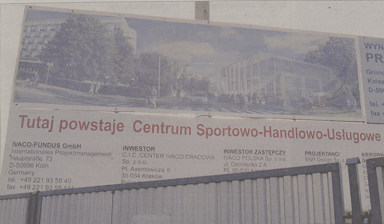
Przyszłościowa, symulacyjna wizja, umieszczona przed placem budowy na eurolakacie, straciła barwy i zdążyła już mocno się pofałdować od wilgoci i śniegu
