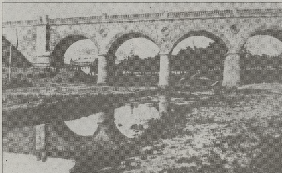
Most kolejowy na Starej Wiśle u zbiegu ul. Dietla i Grzegorzeckiej
