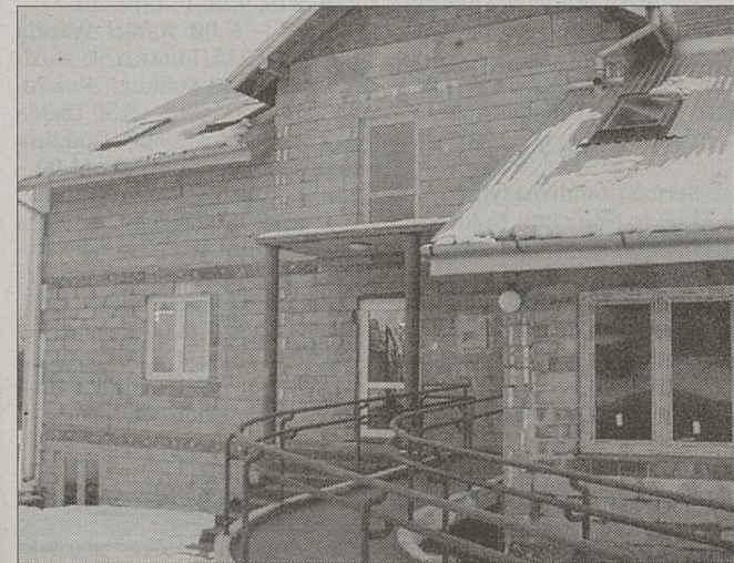
Całkowite zakończenie inwestycji planowane jest na rok przyszły
