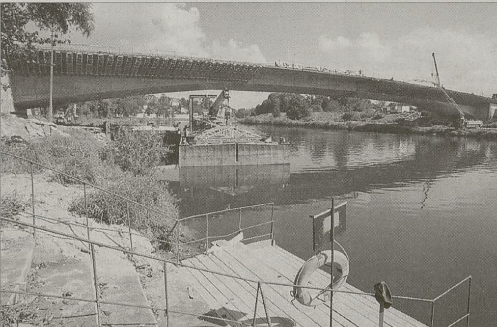
Wczoraj rano brakowało jeszcze 1,5 metra mostu; od popołudnia był już cały – w stanie surowym
