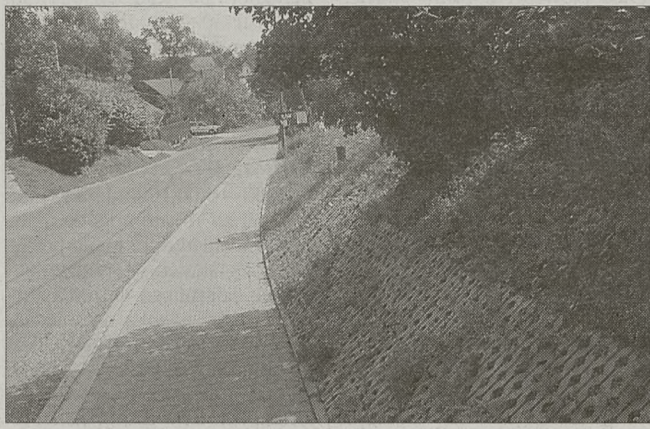
Przy drodze powiatowej w Zastowie kontynuowana będzie budowa chodników
