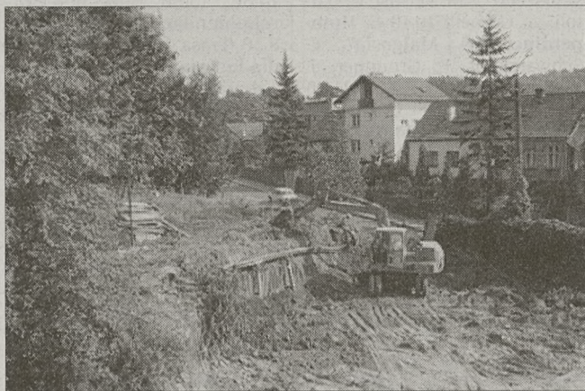
Trwa budowa odcinka drogi łączącej pałac z ul. Słowackiego
