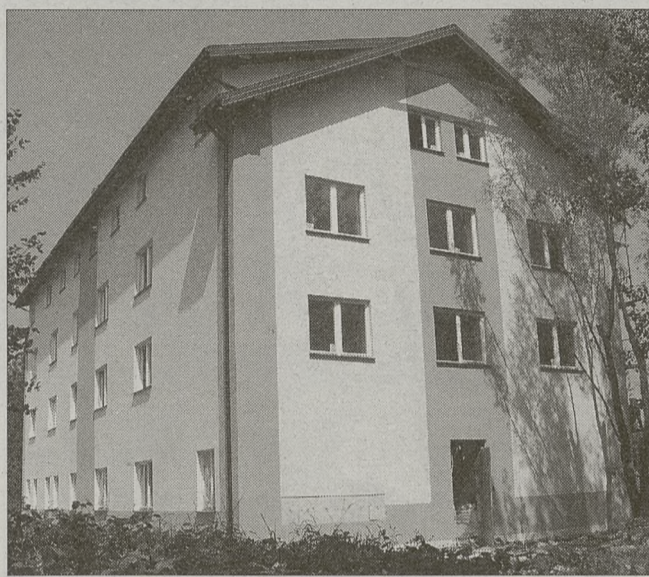
W przyszłym miesiącu zakończy się budowa schroniska ufundowanego przez prywatną osobę; w sąsiedztwie powstanie kolejny obiekt Fot. Piotr Kędziarski
