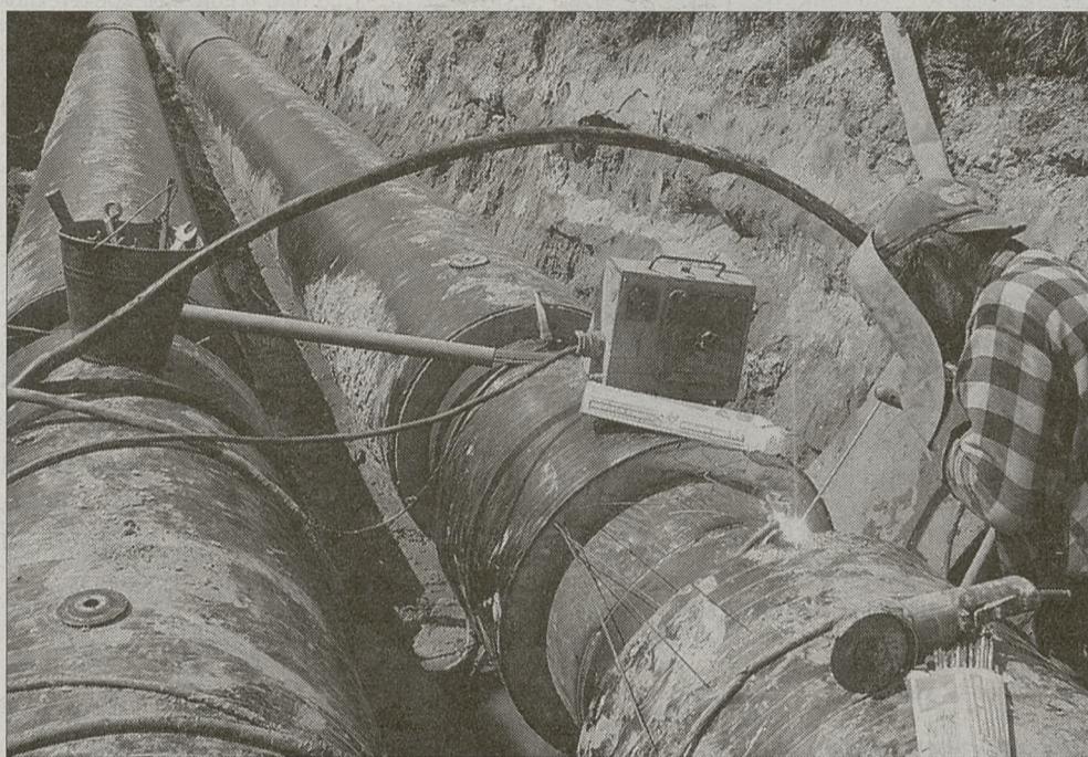
Najważniejsze prace dotyczące sieci ciepłowniczej Krakowa, przy łączeniu dwóch głównych magistrali, trwają w rejonie ul. Walerego Sławka Fot. Piotr Kędziński
