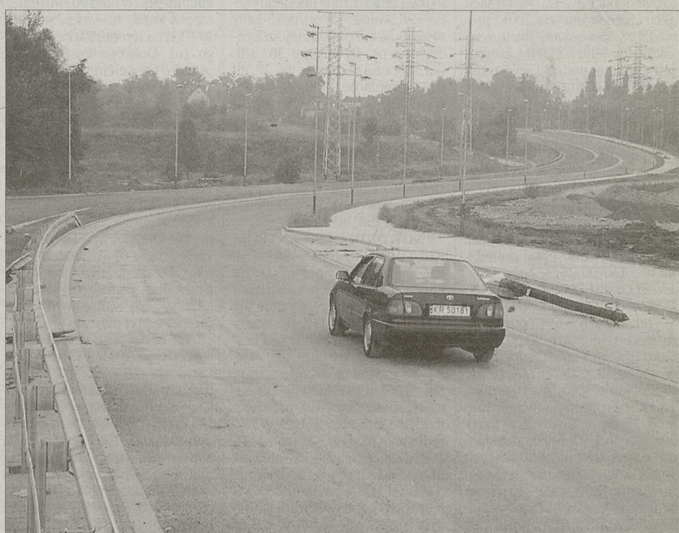
Gotowa jest już większa część układu drogowego ulicy
