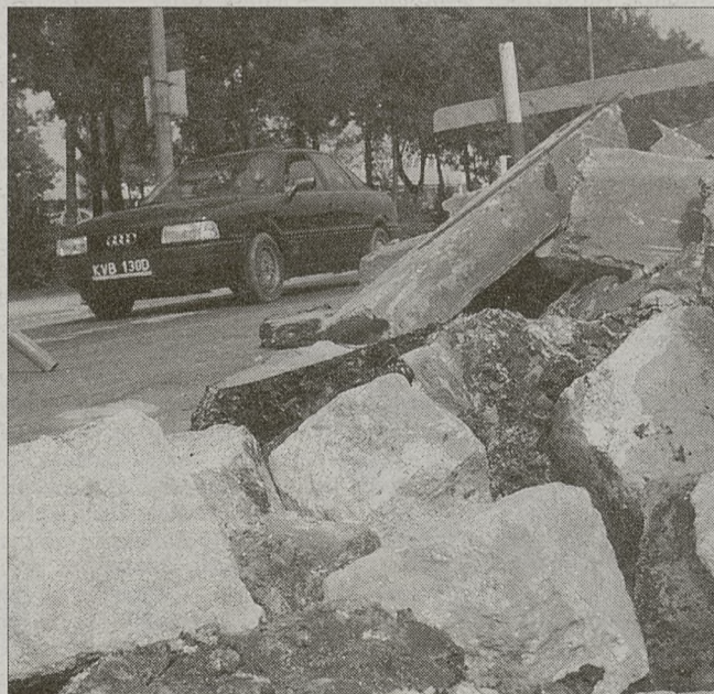
Przy budowie nowej nawierzchni można wykorzystać granitową kostkę z al. Jana Pawła II
