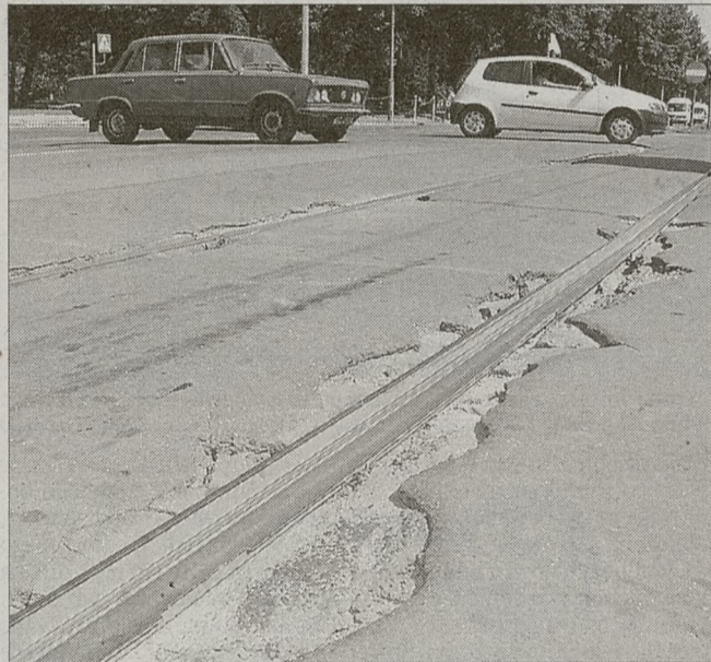
Na al. Solidarności przebudowane mają być rozsypane się już przejazdy przez torowisko. Fot. Piotr Kędziński
