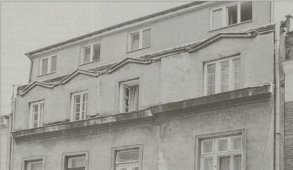
W świetle prawa, mieszkań w nadbudowanej części kamienicy przy ul. Urzędniczej nie ma
