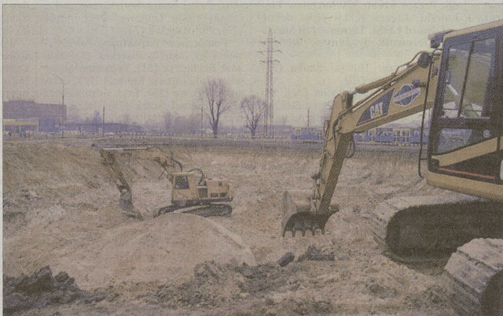
Przebudowa węzła ul. Jana Pawła II, Nowohuckiej i Izydora „Stella” Sawickiego ma zakończyć się w grudniu Fot. Anna Kaczmarsz
