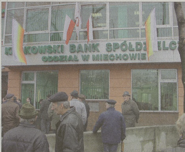
Tak wygląda nowy obiekt banku przy Rynku 16 w Miechowie
