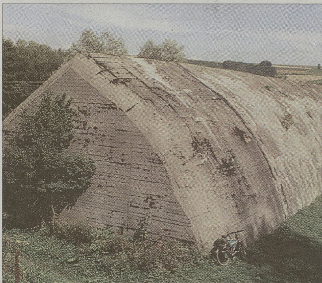
Bunkier „tunelowy” w Stępień
