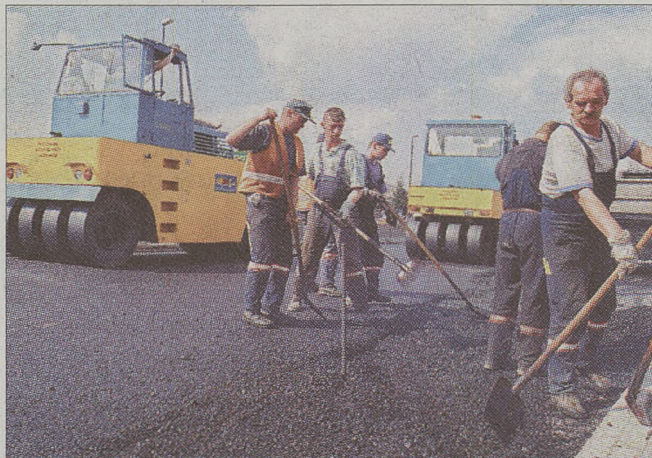
Przy skrzyżowaniu ul. Monte Cassino z ul. Kapelanka prace mają trwać do końca roku. Będą tamtędy prowadzić dojazdy do wznoszonego mostu Zwierzynieckiego Fot. Piotr Kędziński
