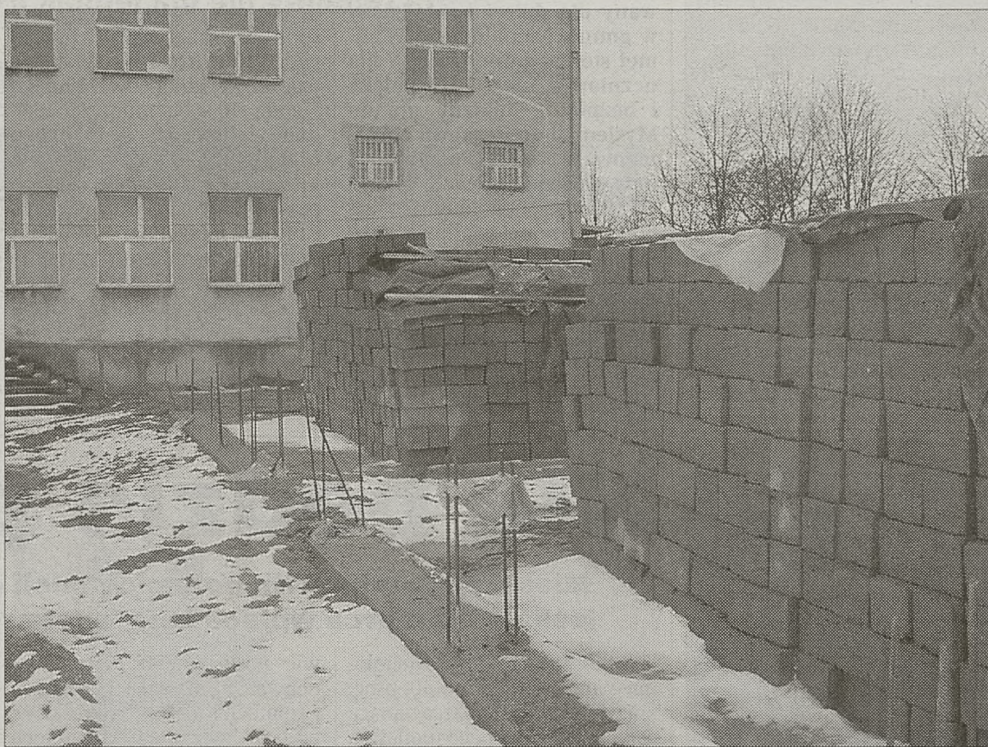
Są już zakupione pustaki na wykonanie ścian – 8300 całych i 700 tzw. połówek
