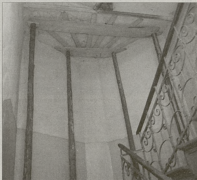
Belki podtrzymujące sufit przy Limanowskiego 45
