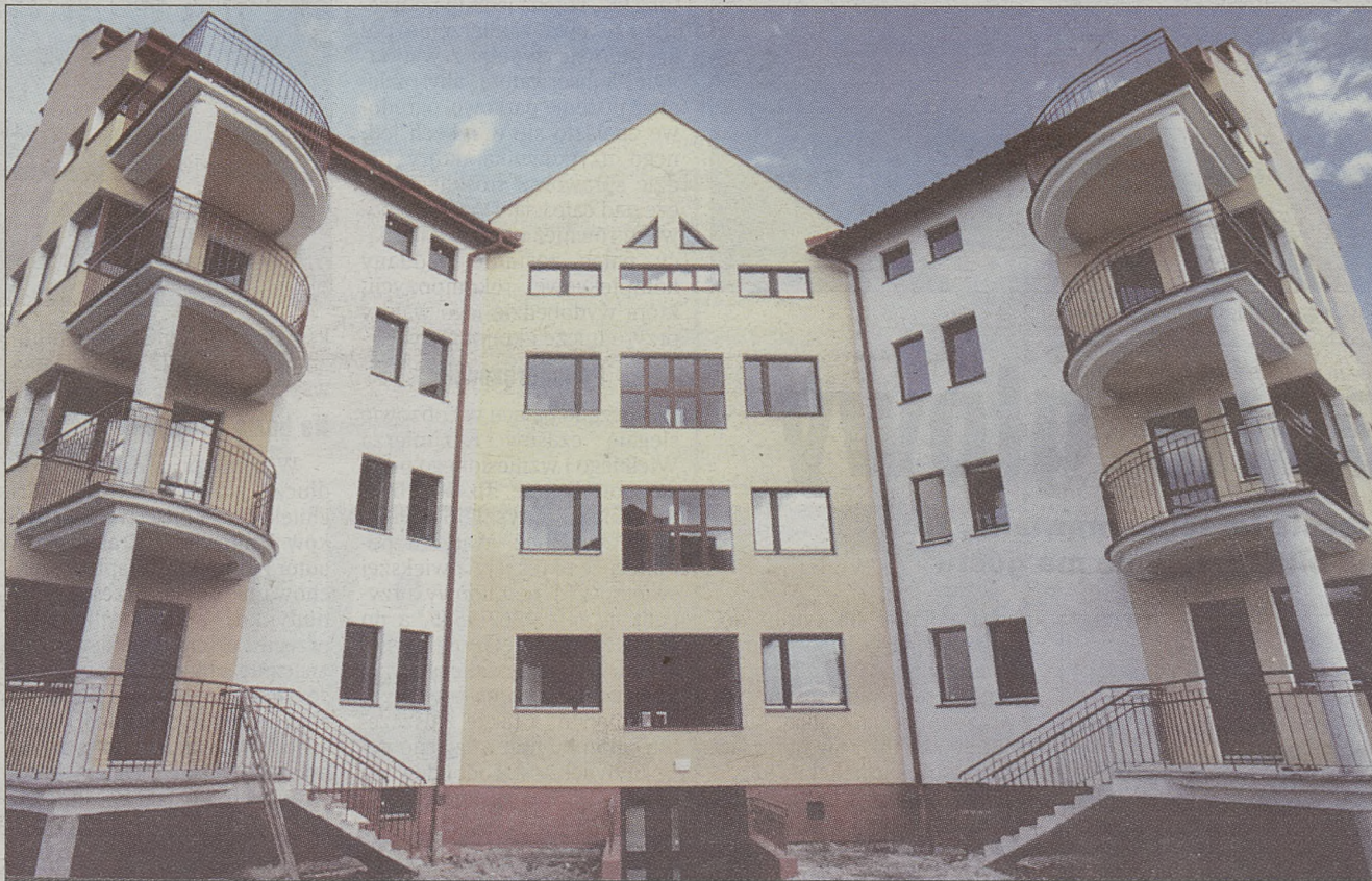
Os. Żabinek, obiekt nagrodzony w konkursie „Budowa Roku 1996” – inwestor SM Ziemia Krakowska
