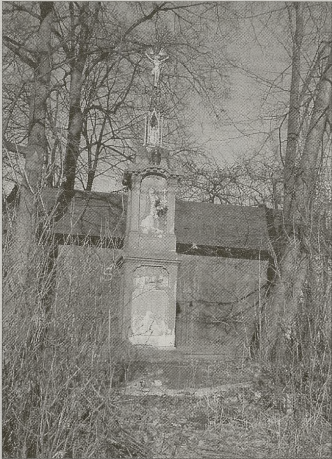
Kapliczka przy ul. Korabnickiej przewidziana w tym roku do remontu...
