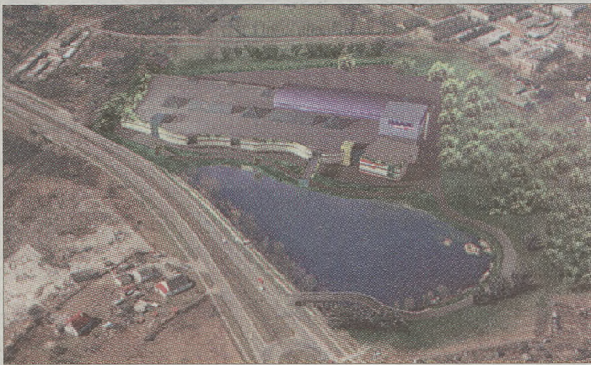
Fasada dwukondygnacyjnego budynku, przez swój falujący kształt, ma nawiązywać do linii brzegowej stawu
