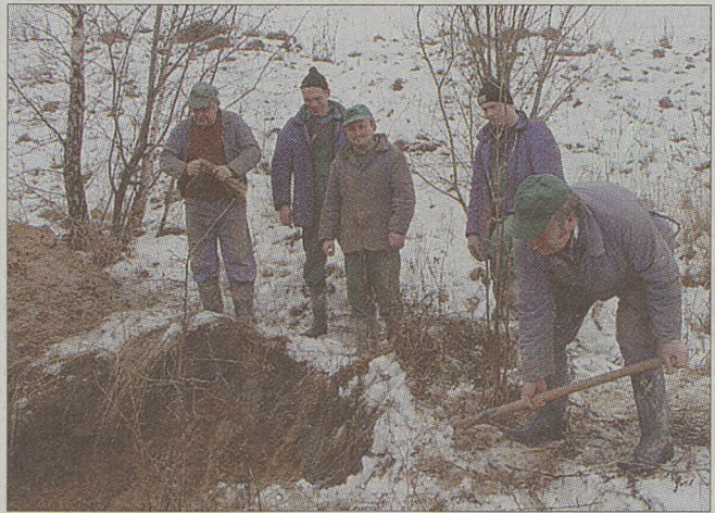
Awarię usuwała cała ekipa miechowskiego Zakładu Wodociągów i Kanalizacji
