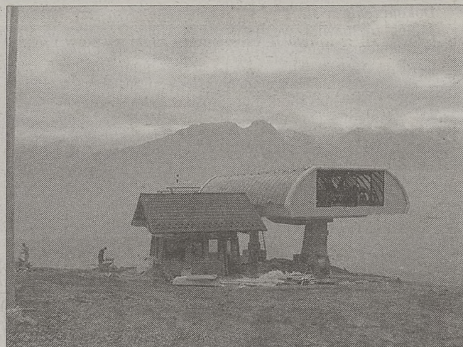
Górna stacja nowego wyciągu na Polanę Szymoszkową Fot. Michał Kowalski
