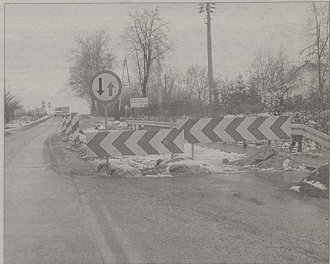
Pół wiaduktu poza ruchem kołowym
