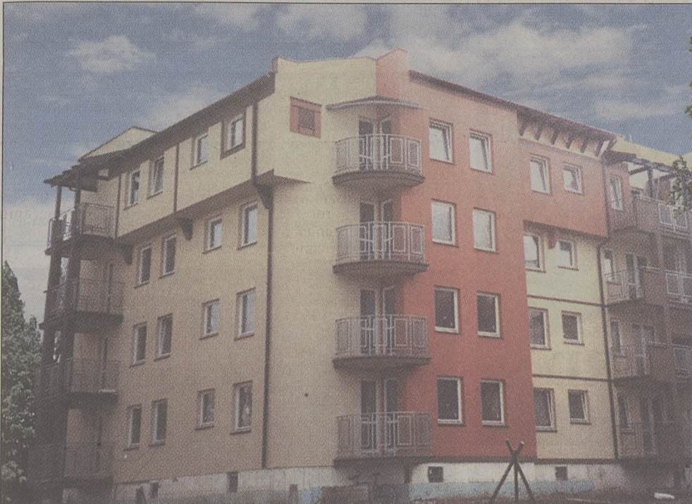
Budynki w końcowej fazie realizacji, stan z września br.
