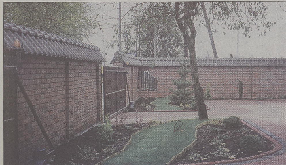
Duże powierzchnie wyłożone kostką są charakterystyczne dla ogrodów w mieście
