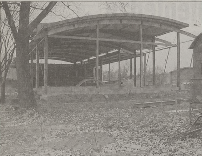
Tak wygląda skawieńska pływalnia, która powinna być gotowa za dwa lata
