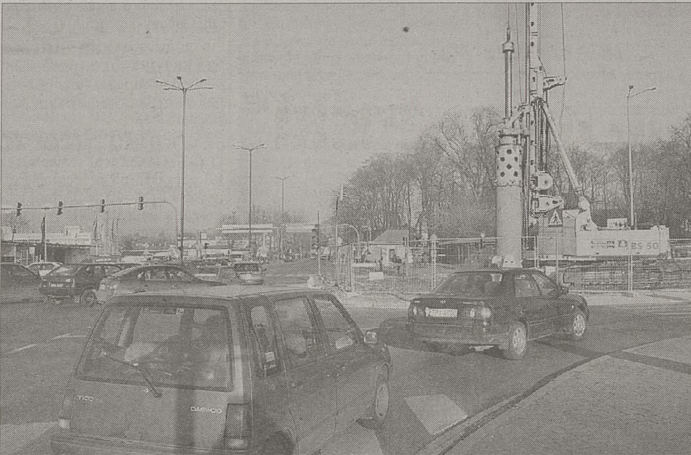
Wiadukt posadowiony będzie na palach zagłębionych około 12 metrów w ziemi.
