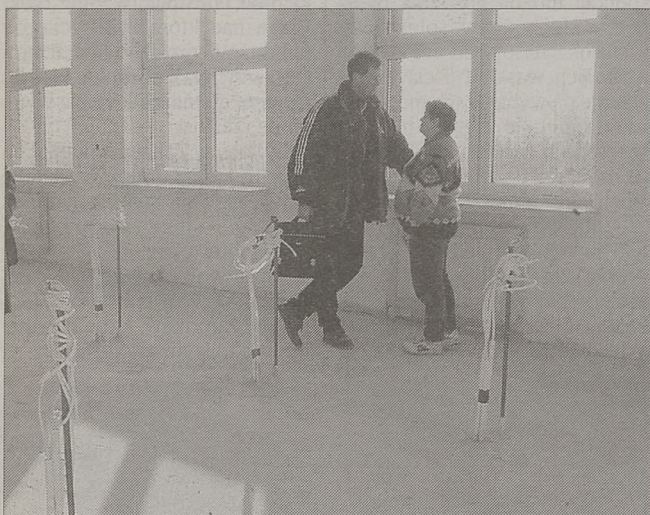
Nauczyciel wf Adam Mrowiec – oglądając pracownię fizyczno-chemiczną – przekonuje kierowniczkę budowy Czesławę Kęskiewicz o konieczności zamontowania wpuszczanych w podłogę słupów w sali gimnastycznej
